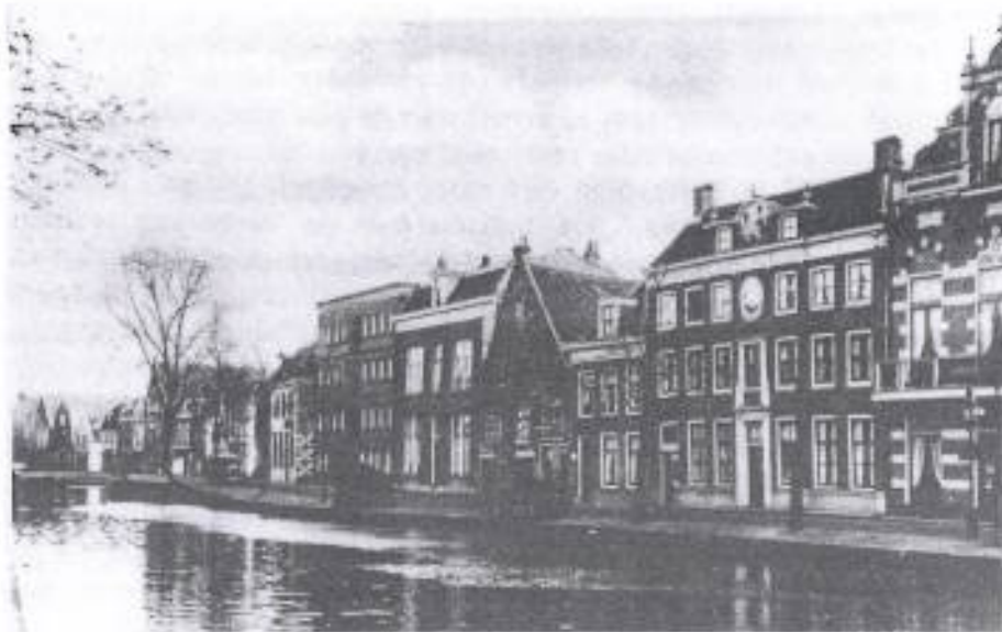
Een beeld van de Weerwal met de ongedempte Where en op de achtergrond de de Spaes-brug. (Foto J. Otsen).
