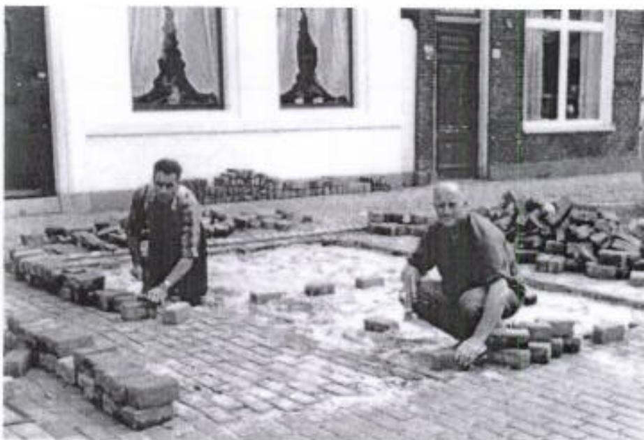
Vanwege het vele en zware verkeer moest de Kanaalschans steeds opnieuw herstraat worden. De foto is van eind jaren zestig met de stratenmakers Hooiberg (rechts) en Roet uit de Beemster.
