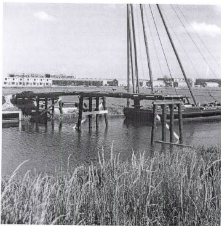
Het bruggetje naar zwembad De Wilgenhoek in aanbouw
