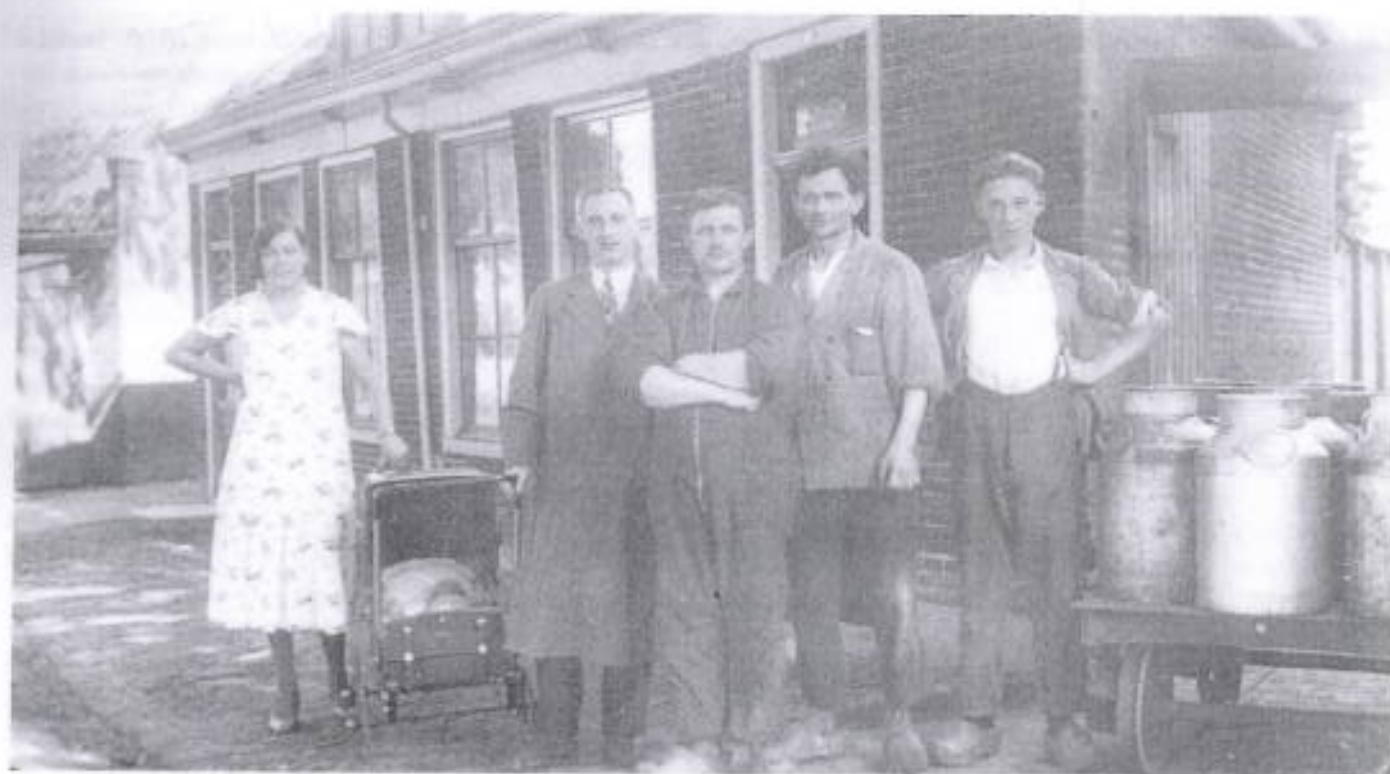
Melkfabriek 'Purmerend'. Rechts de lorrie met melkbussen op het Tramplein. De steeg links is de Oude Sluis. Van links naar rechts mevrouw Stam, H. van Lingen (van het Heerenlogement), P. Velzeboer, N. van de Pouw en Ch. Stander. (foto: J. Velzeboer)
