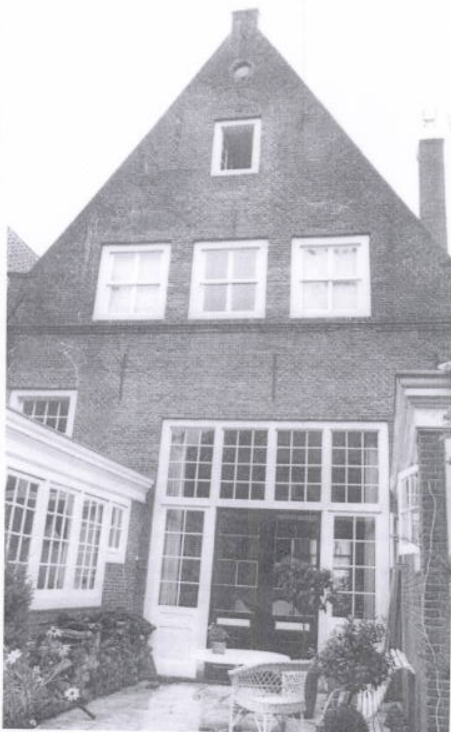
Achtergevel is oorspronkelijk zeventiende eeuw.
