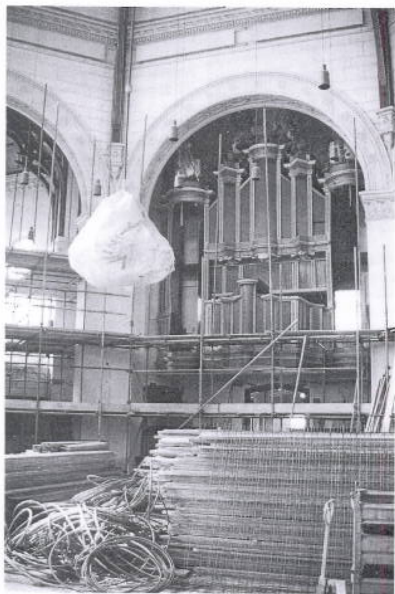
Hoge steigers om muren en pilaren op te knappen en technische apparatuur aan te brengen. Foto: Ber de Lange, 7 juli 1999
