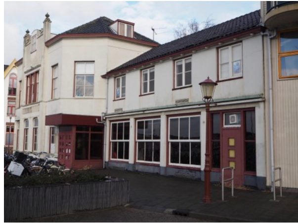
Uitbreiding uit 1950 aan zijde Nieuwegracht.
