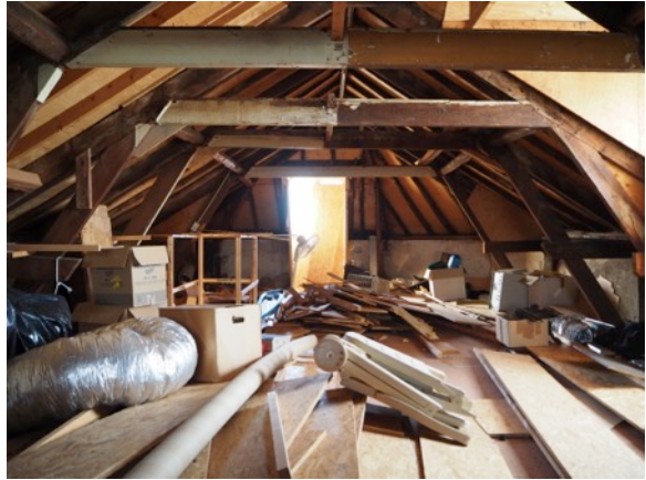
Zolder met originele kapconstructie.
